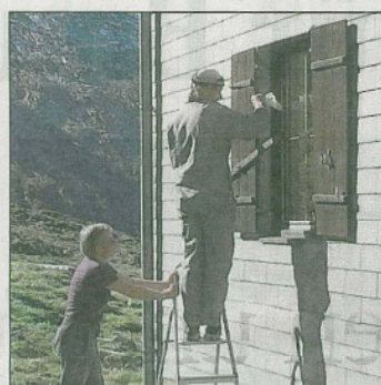
Die Fensterläden an der Hütte wurden gestrichen und verschlossen.
